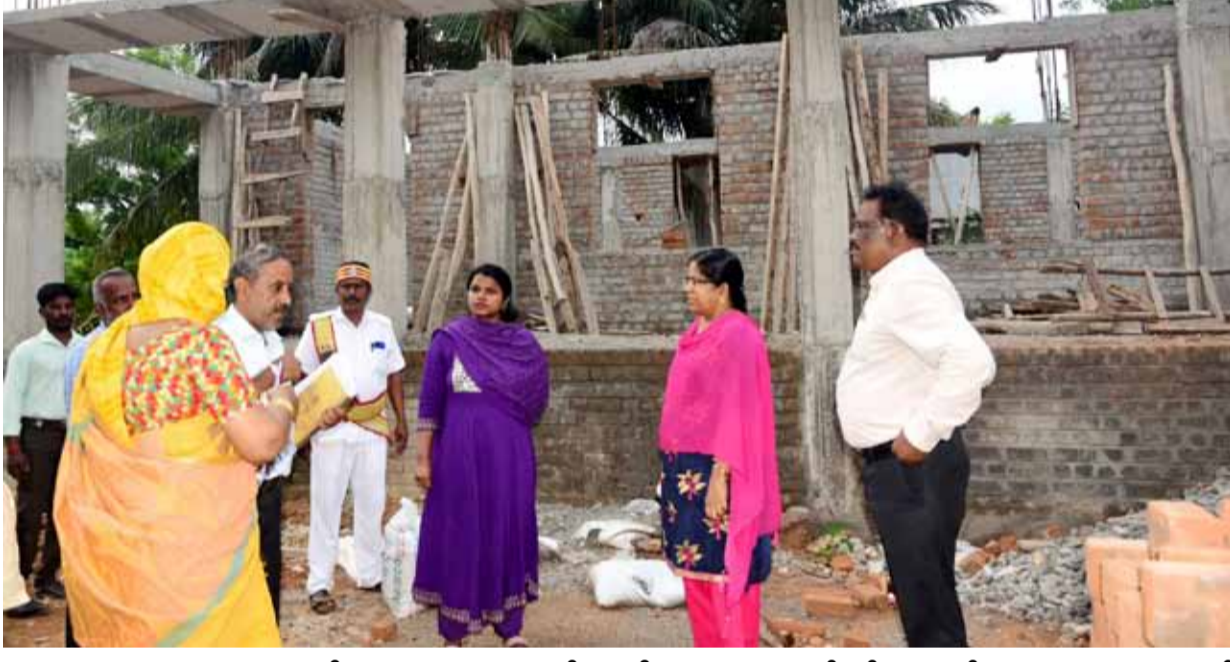
புதுக்கோட்டை மாவட்டம், திருவரங்குளம் ஊராட்சி ஒன்றியம், மாஞ்சான்விடுதி ஊராட்சி, பாப்பன்பட்டி ஊராட்சி ஒன்றிய துவக்கப் பள்ளியில், குழந்தைநேய பள்ளி உட்கட்டமைப்பு திட்டத்தின்கீழ் 2 வகுப்பகங்களைக் கட்டும் பள்ளிக்கட்டிடத்தின் கட்டுமானப் பணியினை, மாவட்ட ஆட்சித்தலைவர் மெர்சி பர்மா, நேற்று நேரில் பார்வையிட்டு ஆய்வு செய்தார். உடன் மாவட்ட ஊரக வளர்ச்சி முகமை திட்ட இயக்குநர் கவிதப்பிரியா, மாவட்ட ஊரக வளர்ச்சித் துறை செயற்பொறியாளர் பாலகிருஷ்ணன் மற்றும் அரசு அலுவலர்கள் பலர் உள்ளனர்.
