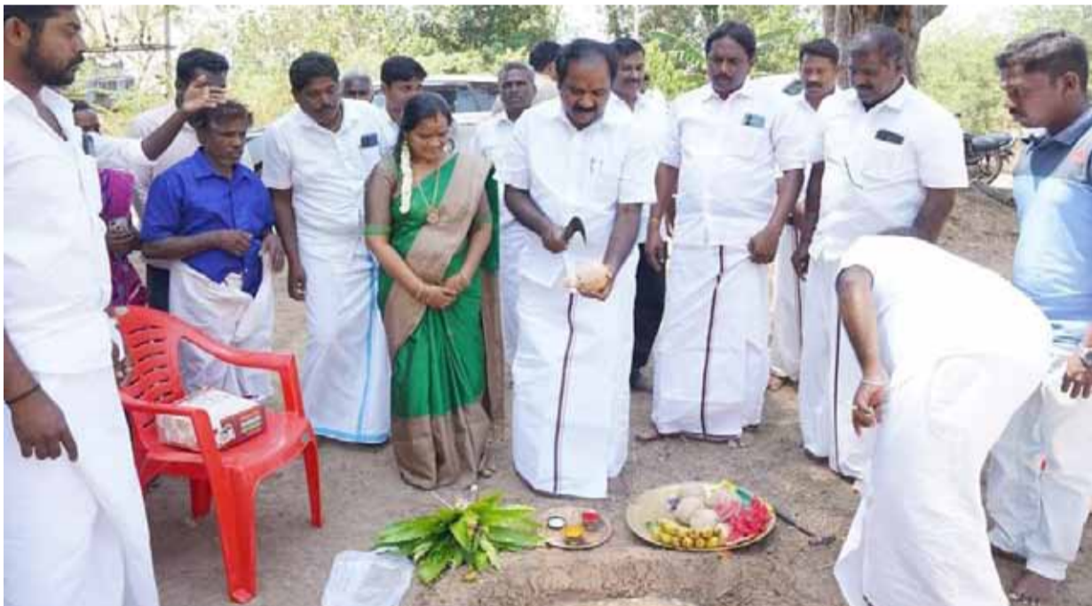
புதுக்கோட்டை மாவட்டம், அறந்தாங்கி ஊராட்சி ஒன்றியம், திருநாளுர் ஊராட்சி, பேராட்சி குடியிருப்பு பகுதியில் புதிதாக அமைக்கப்பட்டுள்ள மின்மாற்றியகளை, சுற்றுச்சூழல் மற்றும் காலநிலை மாற்றத்துறை அமைச்சர் சிவ. வி.மெய்யநாதன் துவக்கி வைத்தார். உடன் அறந்தாங்கி வருவாய் கோட்டட்சியர் சிவக்குமார், அறந்தாங்கி ஒன்றியக்குழுத் தலைவர் மகேஸ்வரி சண்முகநாதன், ஒன்றியக் குழு உறுப்பினர் சுமதி மெய்யநாதன், உள்ளாட்சி அமைப்புகளின் பிரதிநிதிகள் மற்றும் அரசு அலுவலர்கள் பலர் உள்ளனர்.
